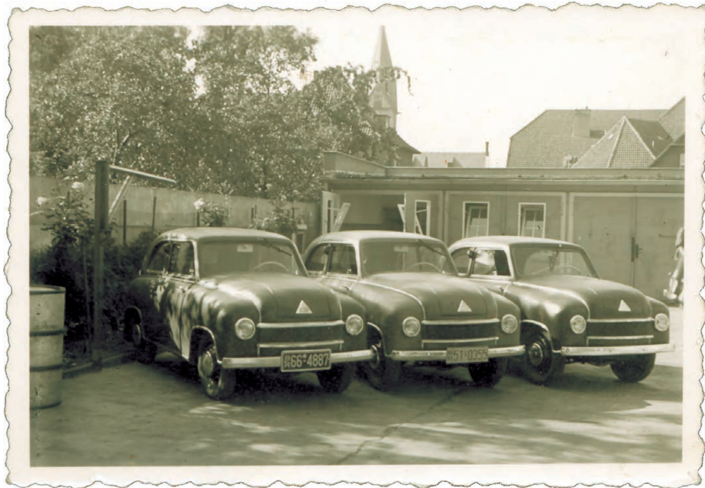
Beginn an der Weststraße 91
