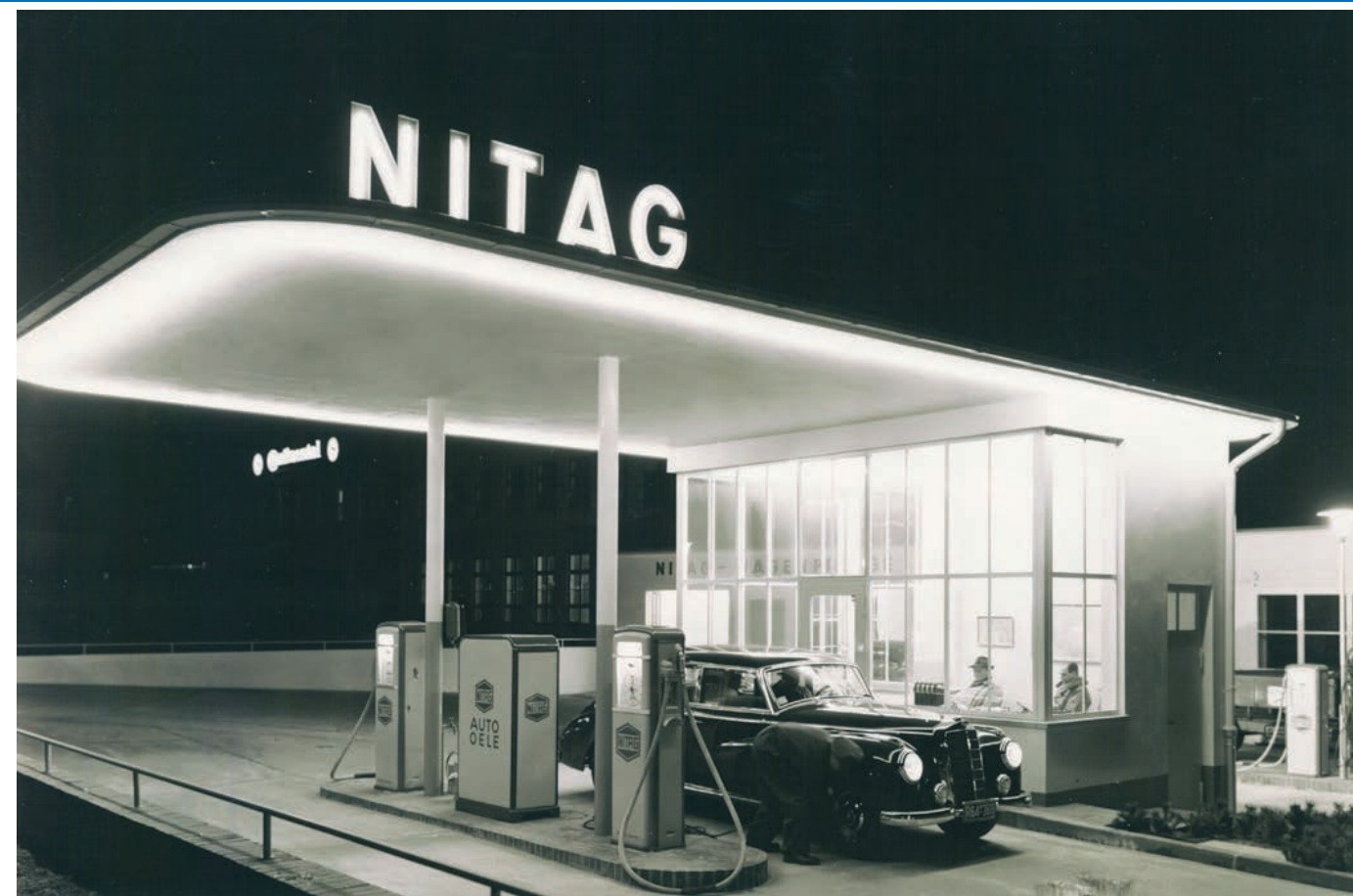
NITAG-Tankstelle Herforder Str. 101 - 103
